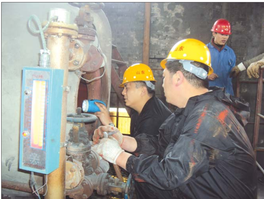
锅炉室检验人员在检验现场。
