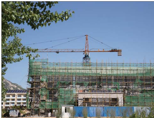
▲正在建设中的威海银滩风雨操场。(资料片)
