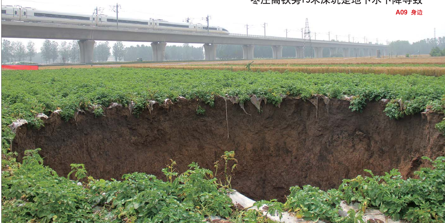
6月1日,滕州市东郭镇西坞沟村高铁旁农田的大坑塌陷原因初步查明,当地政府人员称,初步分析是因干旱造成地下水位下降所致。5月26日早上5点35分左右,该处农田突然塌下去一个13米深、最大直径12.5米的坑,距京沪高铁线仅80多米,引起社会关注。事发后,地质部门和铁路部门前往现场进行了勘察,目前深坑无扩大迹象。本报记者 甘倩茹 摄
