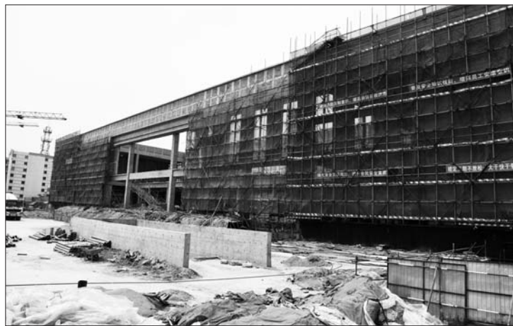
6月28日,德州火车站站房主体已基本建成,7月上旬将开始进行钢结构屋顶的建设。 本报记者 马志勇 摄
