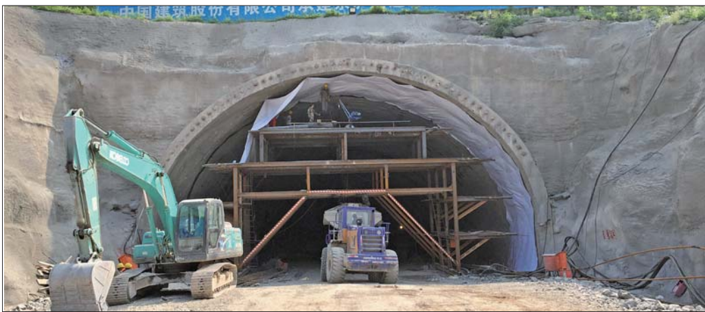
正在施工的龙鼎隧道。 本报记者 宋磊 摄
