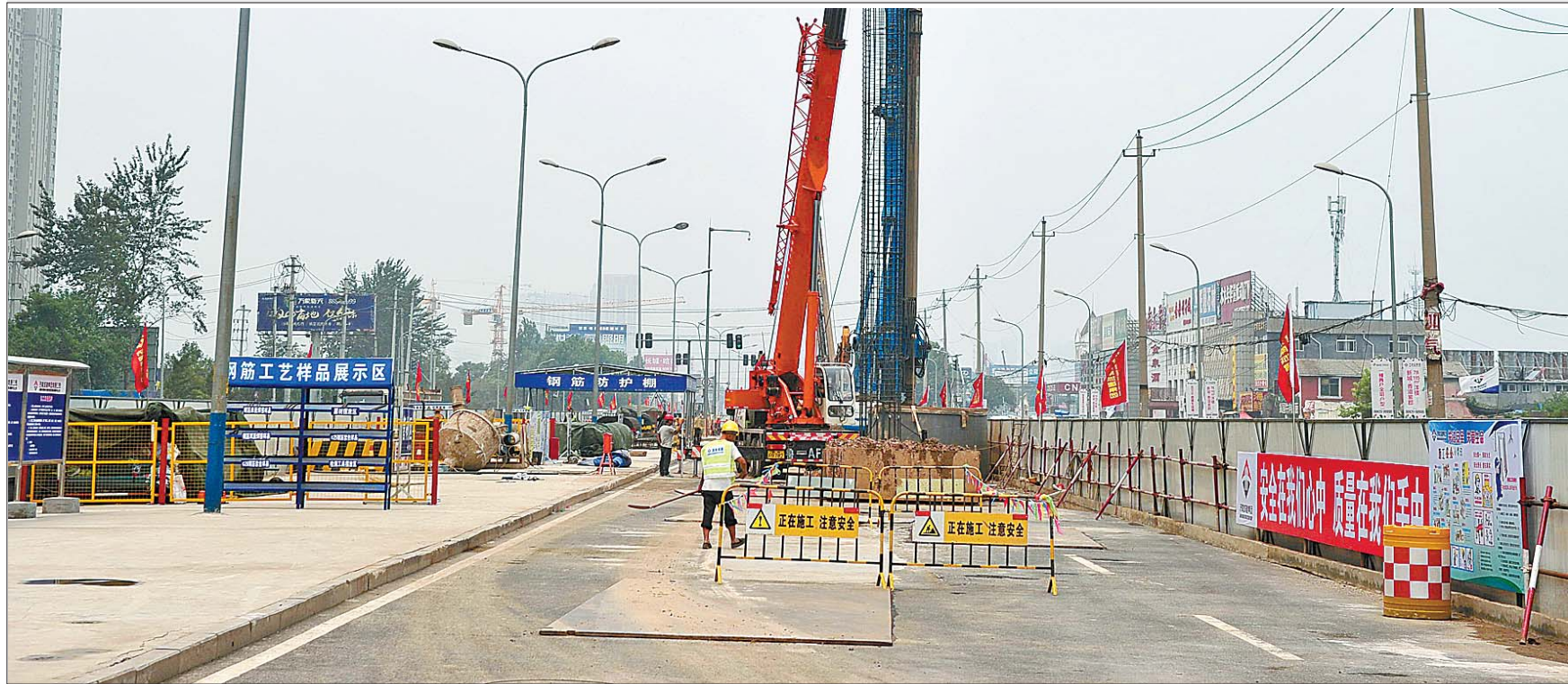
轨道交通R3线工业北路施工现场。本报记者 周青先 摄
