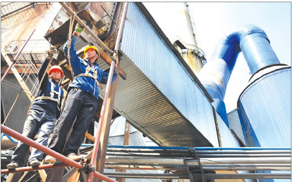
东郊热电升级烟气治理设施,工人拆除脱硫塔相关设施。(资料片)
