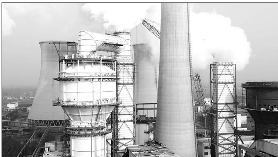
米黄色的火炬型的设施是运河电厂新增的超低排放装置。(资料片)
