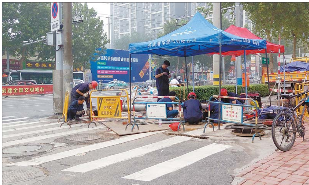
在泺源大街与历山路路口，燃气管线正在施工。本报记者 孟燕 摄
