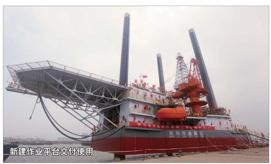
7月19日,中石化重点投资建设项目。 ──胜利井下作业公司"胜利作业新三"平台在历时18个月的精细建造后,成功交付并投入使用。据了解,该三桩腿电动齿轮齿条升降式 平台最大作业水深25米、最大作业井深5500米,一次就位最多可进行20口井的修井、侧钻及辅助试油施工。此外,该平台首次采用悬臂梁斜块锁紧装置并安装声呐侧水深装置和 雷达扫描装置,有效提高稳定性与安全性。胜利作业新三平台监造组组长王小伟表示,该平台很快将赶赴埕岛海域施工,此举为提升胜利井下海上作业施工优质高效打下坚实 本报记者 邵芳 通讯员 陈冉 徐海 摄影报道
