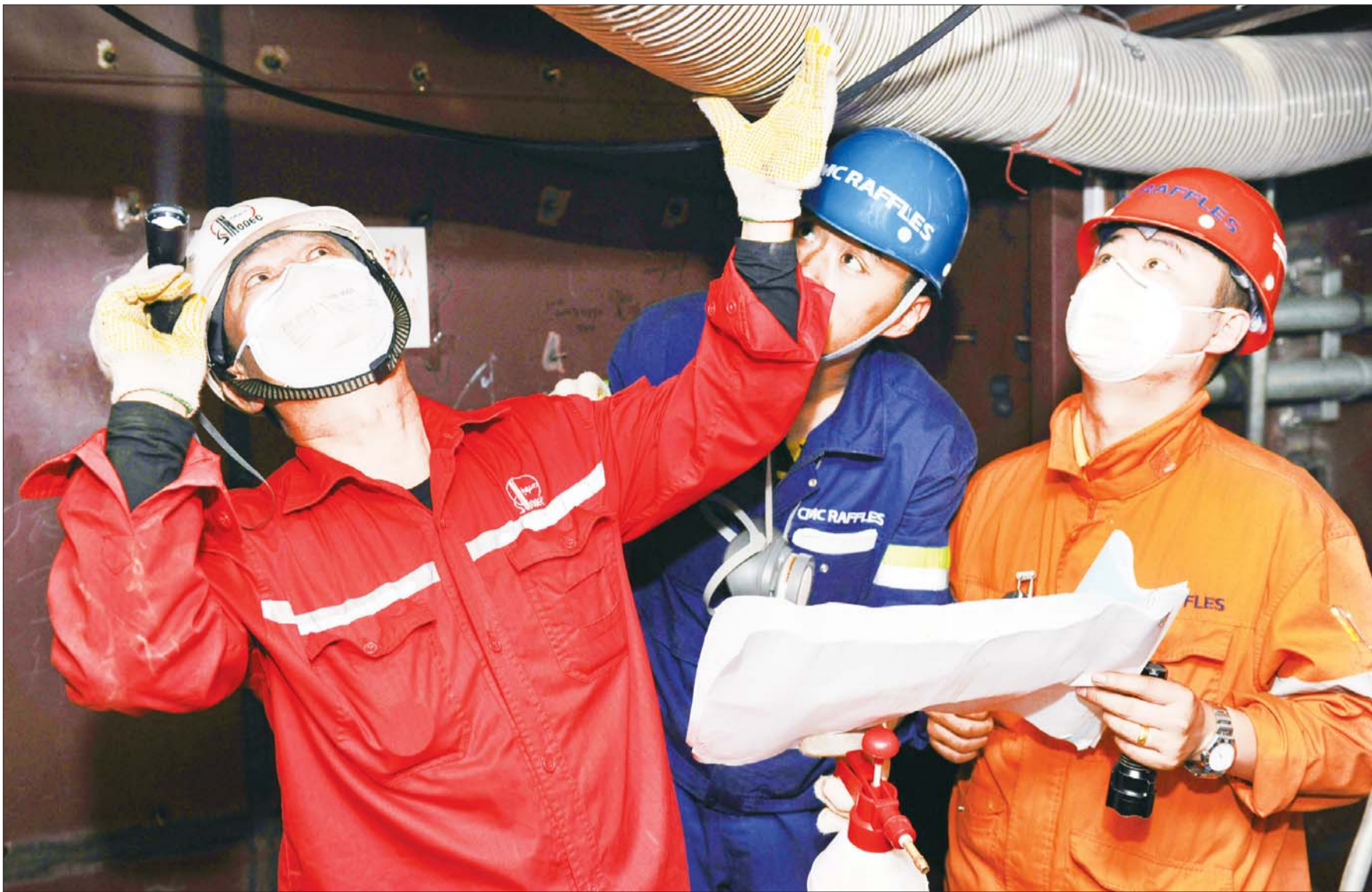
胜利90米钻井平台项目组严格监造确保平台建造质量。 本报通讯员 王为 摄
