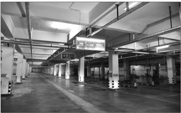
改造中的地下停车场。 本报记者 马志勇 摄
