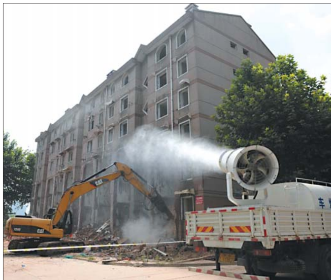
CBD(安置区)旧改项目国有土地上房屋征收进入拆除阶段。
