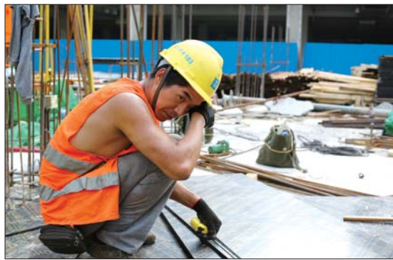
◀ 热燥燥的工地上,工人的汗水浸湿衣服。
