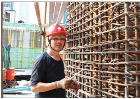
汉峪金谷工地上,工人们加紧工程建设。
