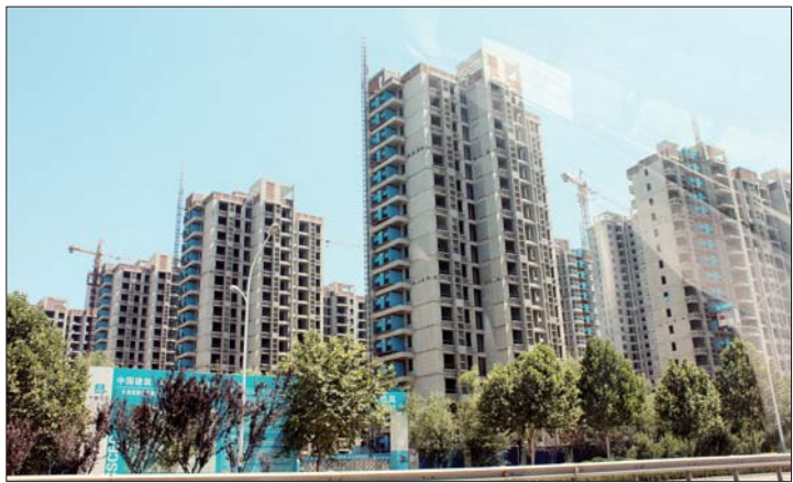
辛庄安置区封顶。
