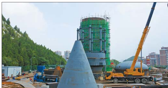
济南热力浆水泉热源厂目前正在进行锅炉改造。
