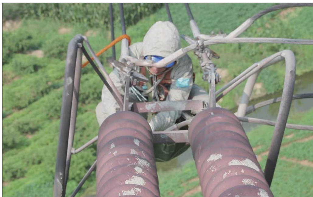
12日下午3点,国网山东电力检修公司的一名工人冒着35℃的高温进行作业。 本报通讯员 郭轶敏 杨森 摄
