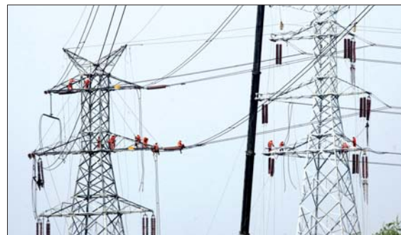
国网德州供电公司加强电网建设。
