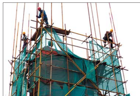
烟囱拆除一段,就要把高出来的围挡脚手架拆除一段。
