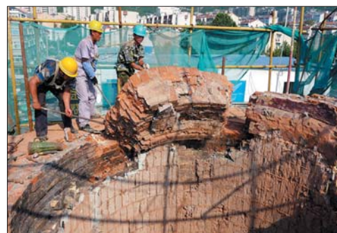
风镐加撬棍,烟囱就这样被一圈圈地拆除了。
