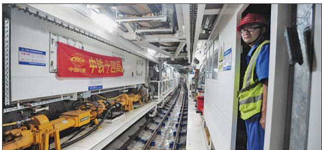
工人在闷热中抓紧施工。 本报记者 周青先 摄
