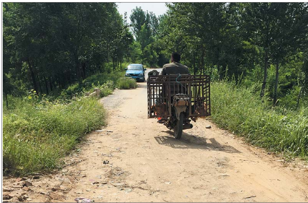
只有残留的一点栏杆能看出这是座桥。 本报记者 邢敏 摄
