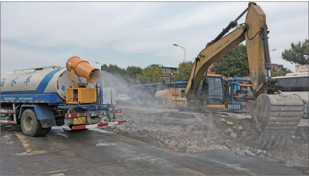
济泺路施工现场不少路段已经挖出了沟槽,喷雾车在进行降尘。
