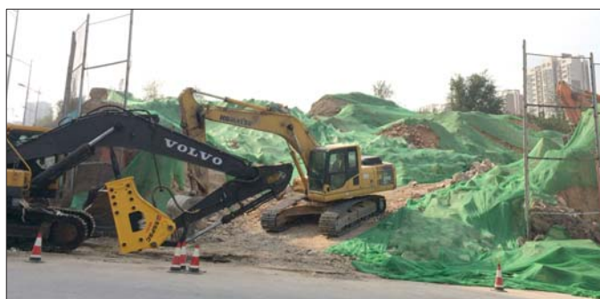
小区外不远处就是施工工地,图为开山现场。
