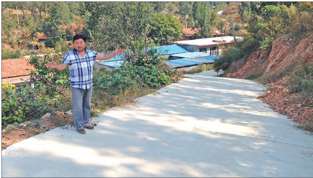
靳伟祥向记者介绍村里刚修好的环山路。
