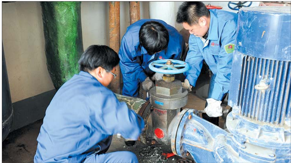
工作人员对供热站进行维修为供暖做准备。资料片
