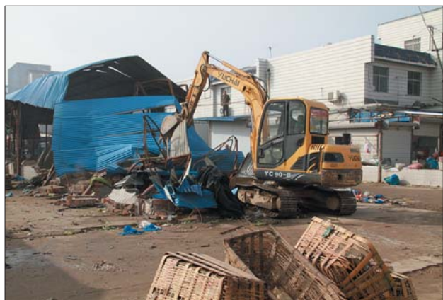
工作人员正依法拆除老农贸市场建筑。
