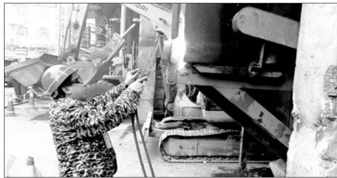
工作人员正在拆除燃煤锅炉房。(资料片)本报记者 蒋龙龙 摄
