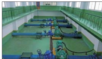
纬一路给水管网 开始改造建设
