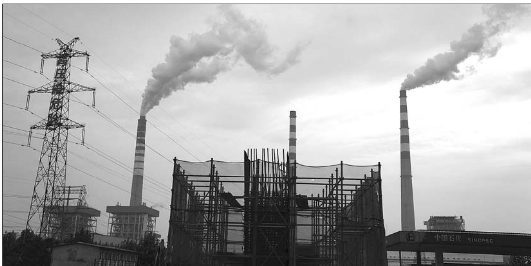
济南工业北路一处筑路工地,其背后是高耸的烟囱。 本报记者 陈文进 摄
