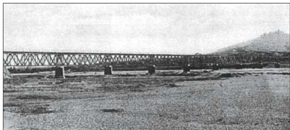
胶济铁路最大桥梁淄河大桥(1905年摄)
