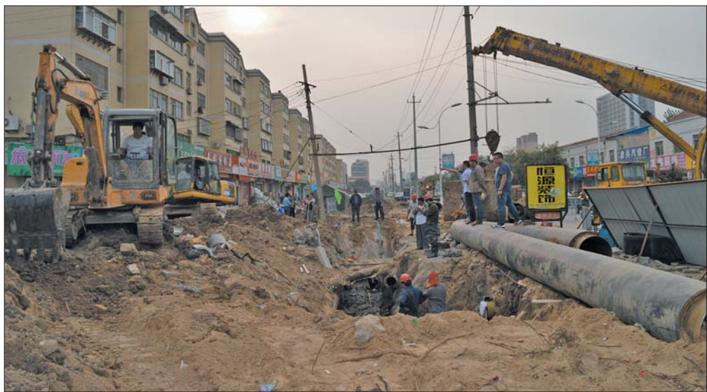
纬一路敷设供热管网。 江亮 摄
