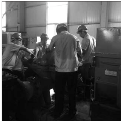
昨日,记者从莱阳市建设局获悉,今年莱阳市将提前10天供热。从7日开始,该市中集中供热将全面启动运行。据了解,按照《莱阳市集中供热管理条例》
