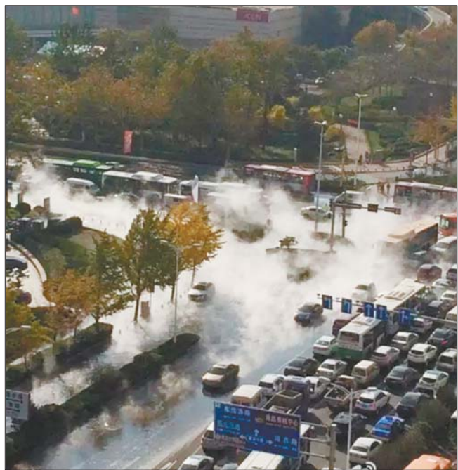
青岛供热管道破裂现场。
