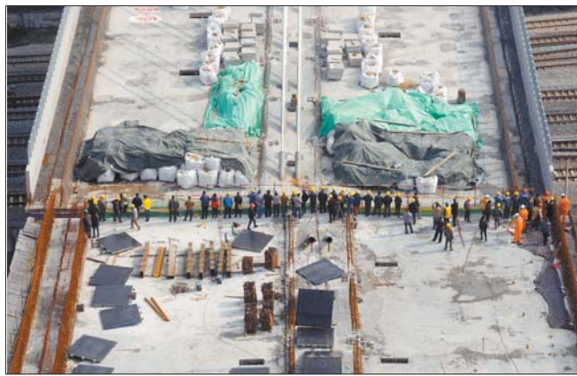
转体完成,与引桥“无缝”对接。本报记者 邓兴宇 摄
