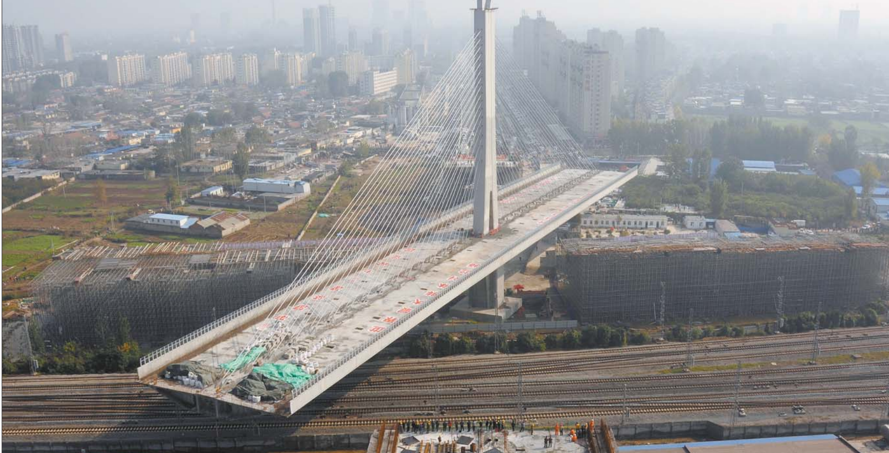
丹阳路跨铁路立交桥东侧主桥正在进行转体。本报记者 邓兴宇 摄
