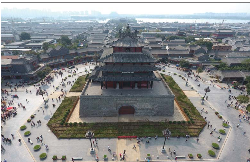
水上古城工程建设进入攻坚收尾阶段。(古城供图)
