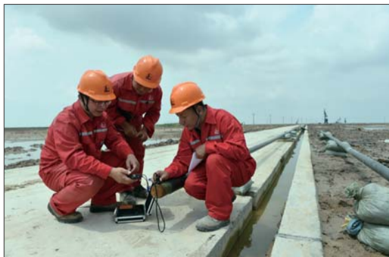
职工正在进行油水井安全隐患治理。
