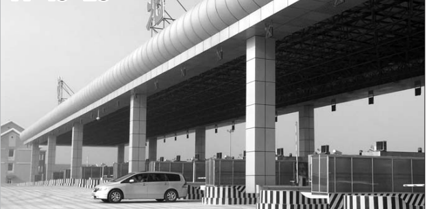
高速开启,第一辆私家车通过收费站。
