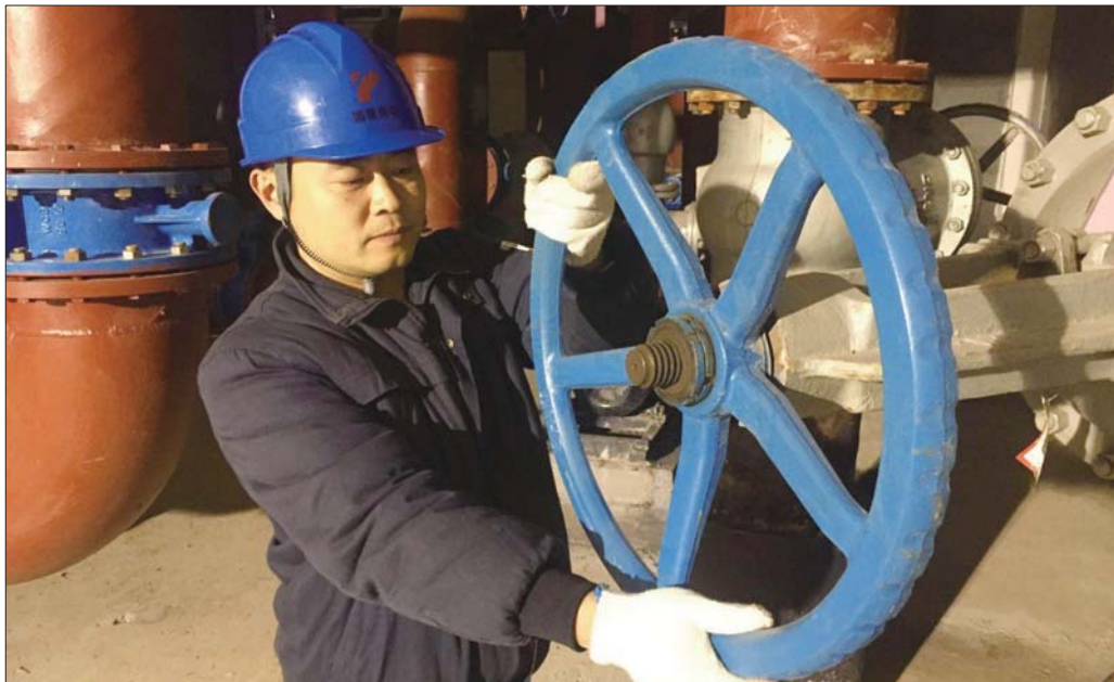
工作人员正在检修供暖设施。 本报见习记者 刘川三 摄
