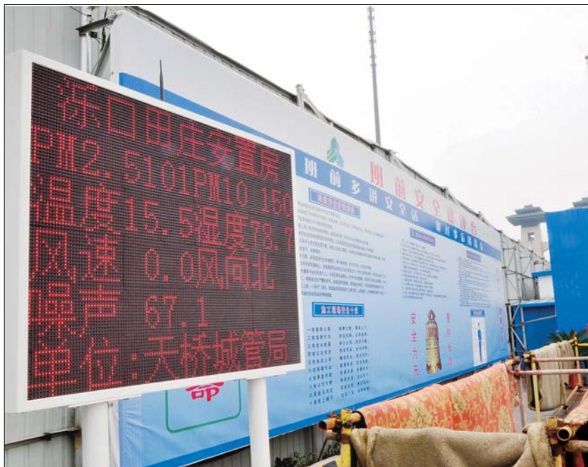
天桥区泺口田庄安置房工地门口, 显示屏实时显示工地的各项监测指标。
