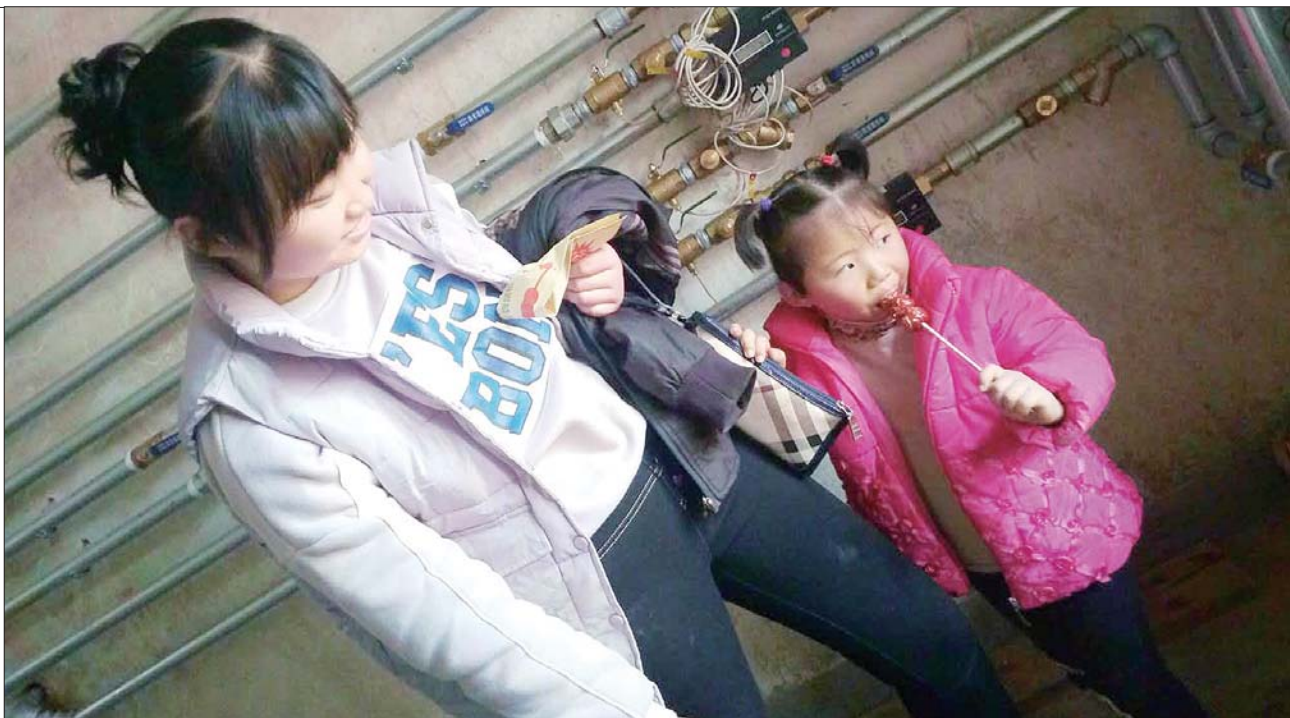
22日上午,孙振、小张夫妇带着女儿前来给安装好的暖气管道试水。
