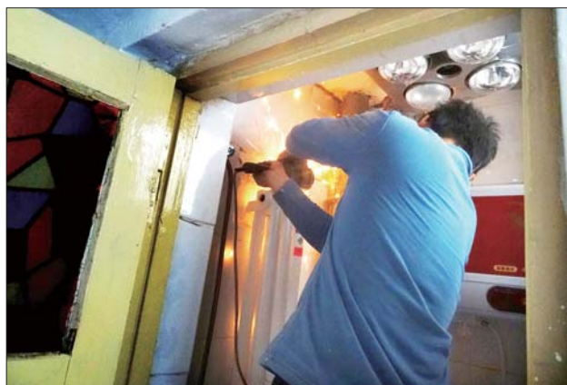
老房子厕所空间小,施工很难伸开手。
