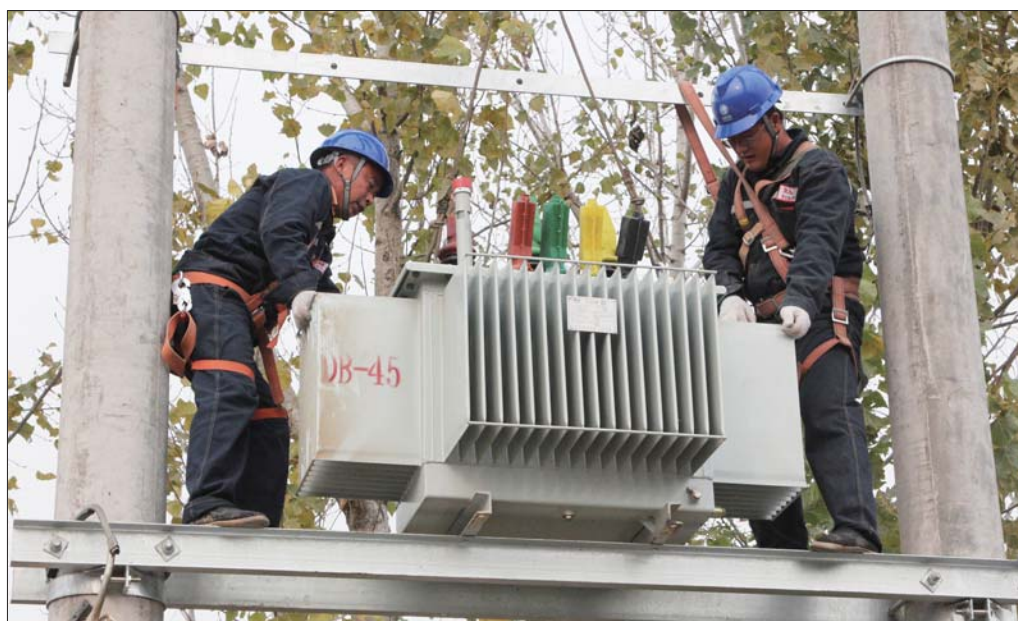
国网齐河县供电公司员工正在为齐河县胡官屯镇姬庄村的电网实施改造。 本报通讯员 王保华 摄
