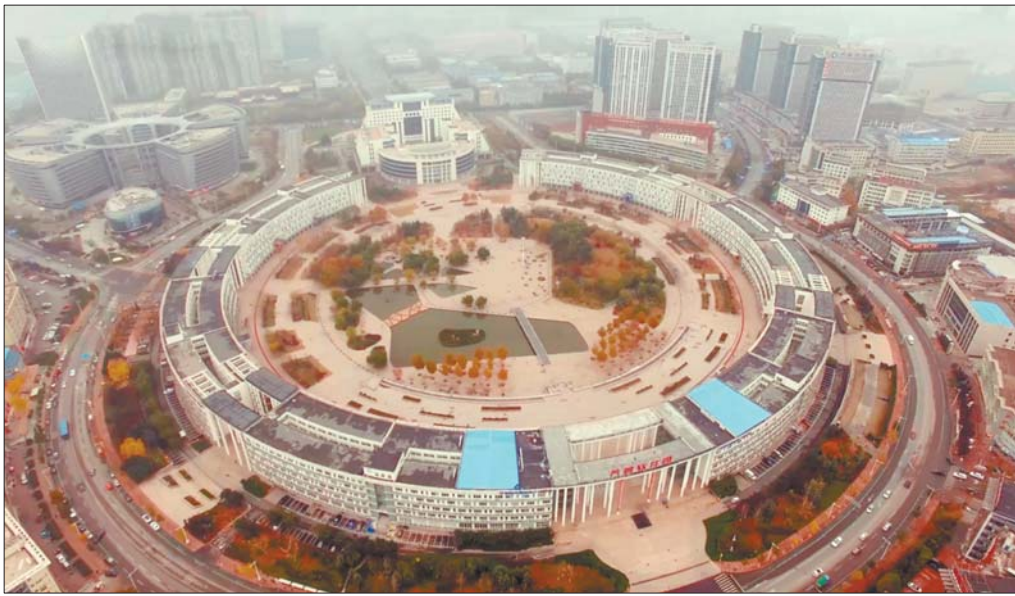
贤文片区齐鲁软件园 济南市勘察测绘研究院航拍图
