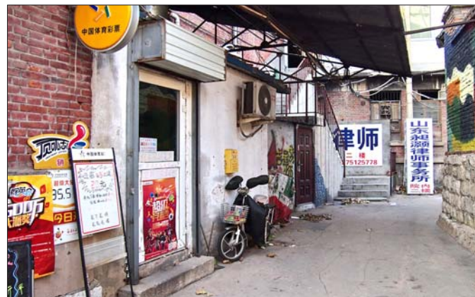
2日,记者在历山路沿线探访,很多小院都有砖混、塑钢、铁皮屋等违章建筑。本报记者 周青先 摄
