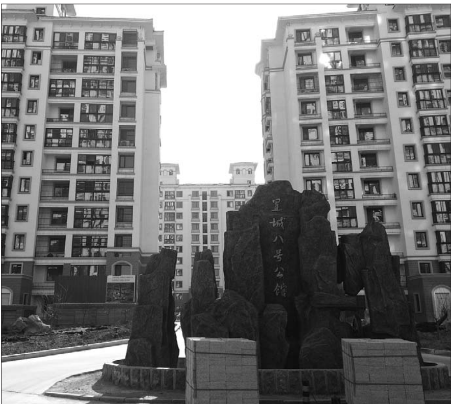
置城8号公馆一些居民家中的暖气不热。
