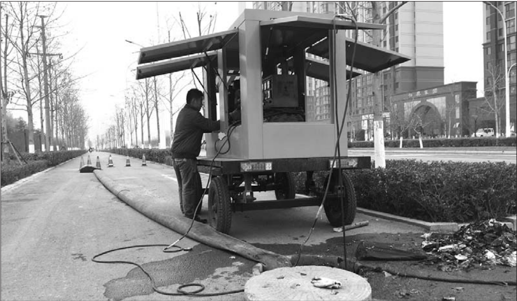
抽干雨水管道内的水排查污染源。
