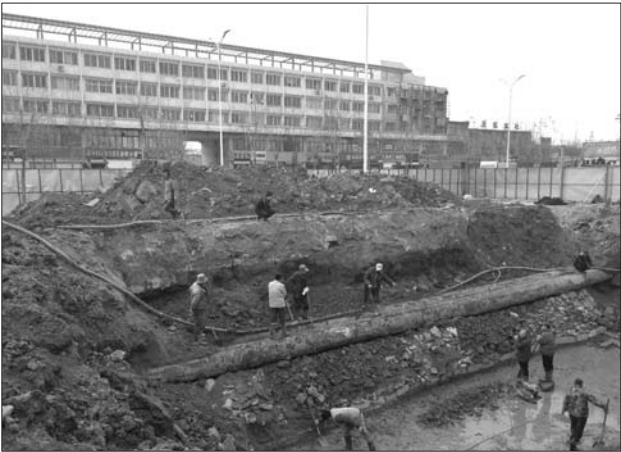
维修人员开始对供暖管道进行加固。
