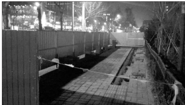
历山路泺源大街交叉口西南角人行辅道上的一处施工点。
