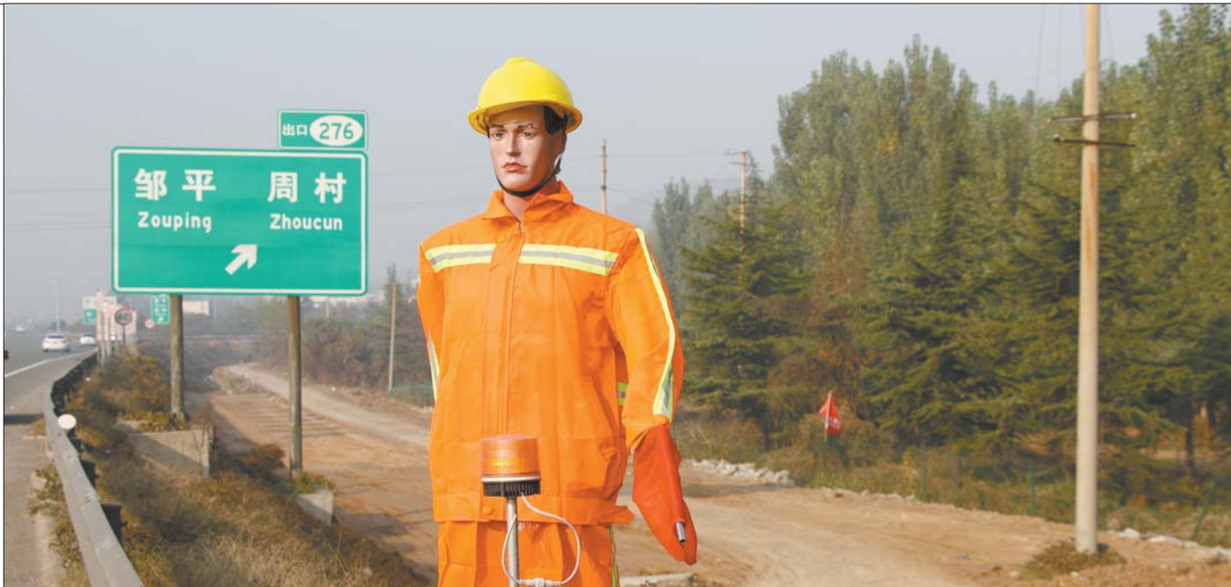
济青高速施工现场设置的太阳能安全指挥员。 东方IC供图
