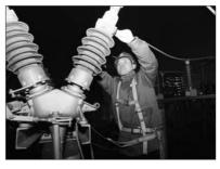
去年12月28日凌晨,110千伏新城变电站2号主变35千 伏侧刀闸触头过热缺陷被成功消除,检修人员克服照明不 足、天气寒冷等诸多不利因素,全力奋战1个多小时完成"零 点消缺"工作,充分保障了居民可靠用电。
