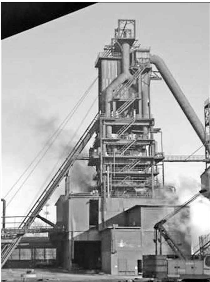
唐山市滦县兴隆钢铁有限公司3号高炉无组织排放严重。 据环保部官网
